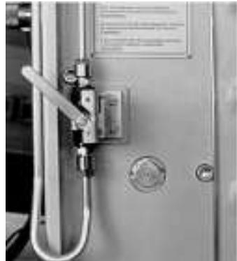
Figur 48 - Steuerventil mit angesetztem Schlüssel
