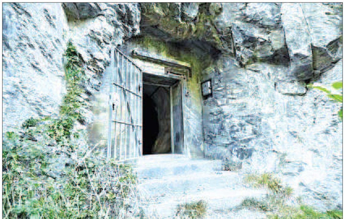
Der ehemaligen Notausgang der Festung Trin wird heute als Eingang benutzt.
