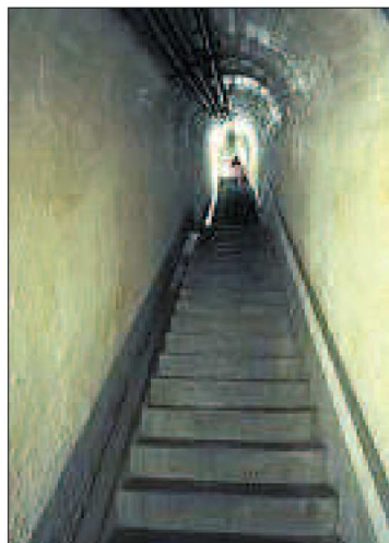
Hunderte steile Treppenstufen verbinden die Anlagen im Felsinnern.
